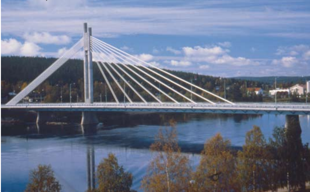
Мост Jätkänkynttilä в Рованиеми, Финляндия
