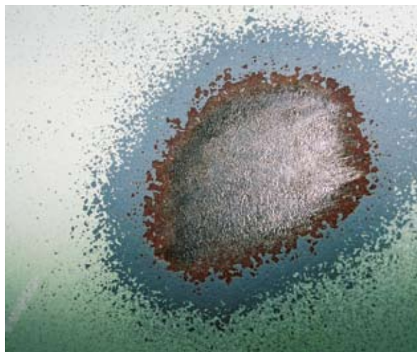
Вид, очищенной до степени Sa2½, ранее окрашенной поверхности для локального ремонта покрытия.
