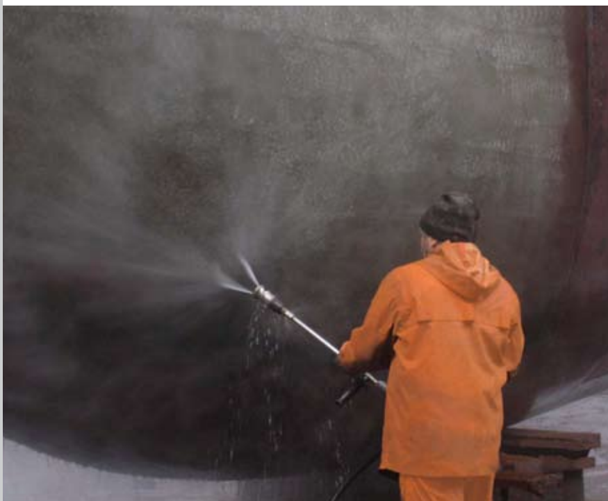
Гидроструйный метод очистки.
