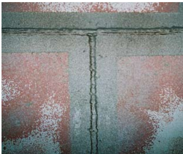
Вид, очищенной до степени Sa2½, ранее окрашенной поверхности для локального ремонта покрытия.
