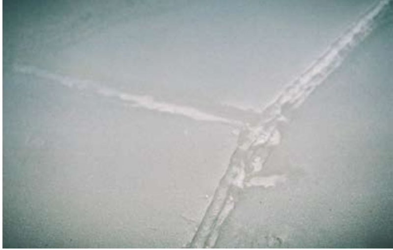
Поверхность после абразивоструйной очистки до степени Sa2½.
