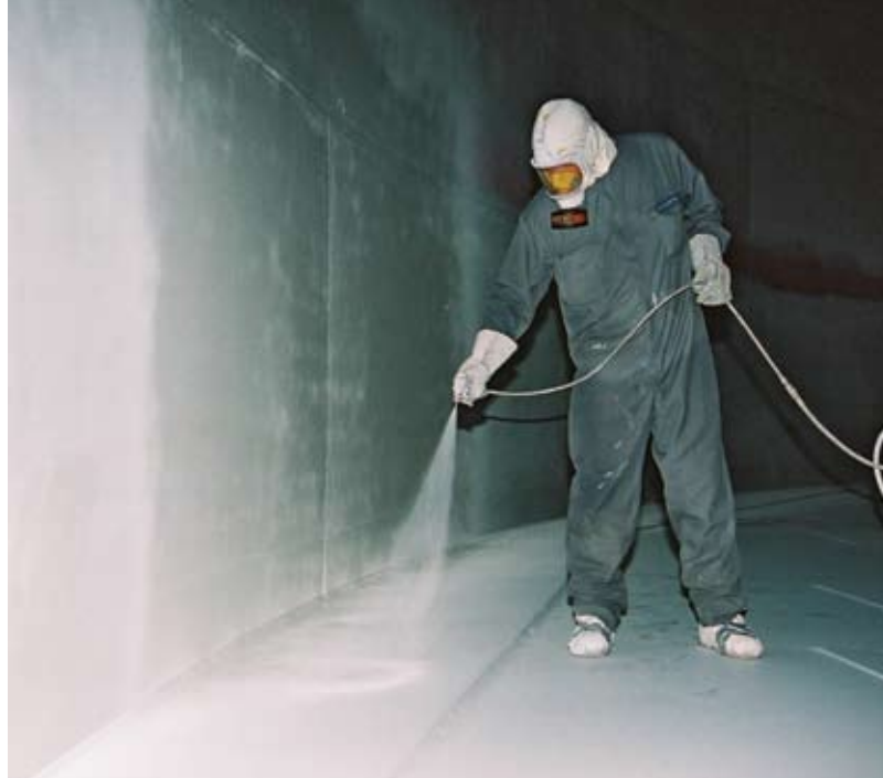
Окраска топливной цистерны.
