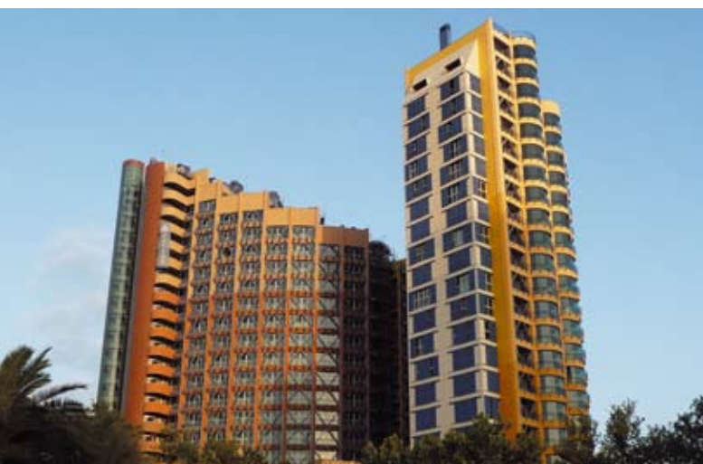
Металлоконструкции жилого комплекса «Новая Александрия» окрашены эпоксиполиуретановой системой Tikkurila
