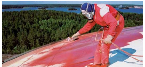
Нанесение Temabond ST 300 на ранее окрашенную поверхность (ремонтная окраска)
